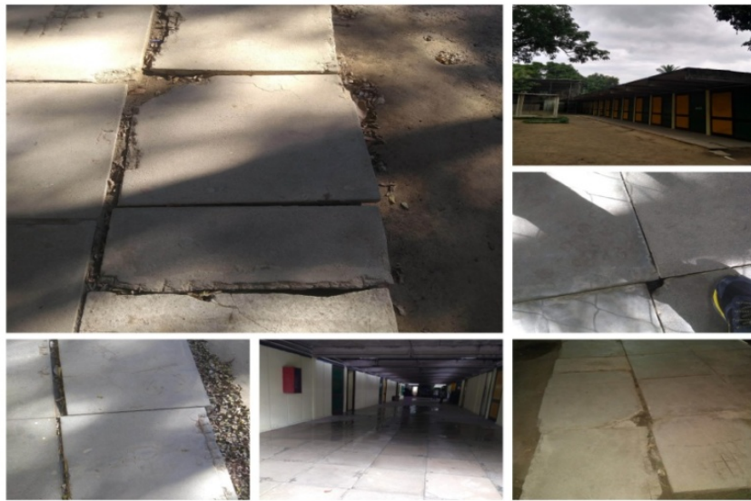
Figura 1 - Piso antes das reformas das obras de melhoria de acessibilidade
